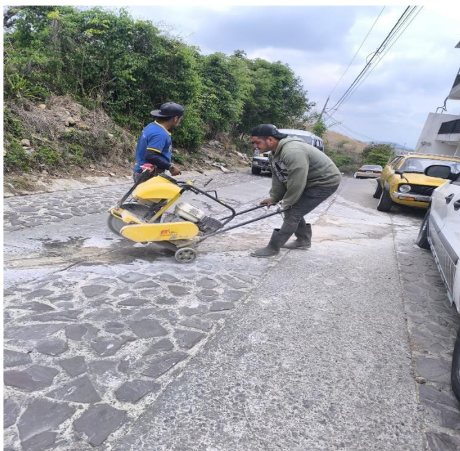
Corte de pavimento para colocación de tubería en camino hacia Laguna Monja Blanca.
