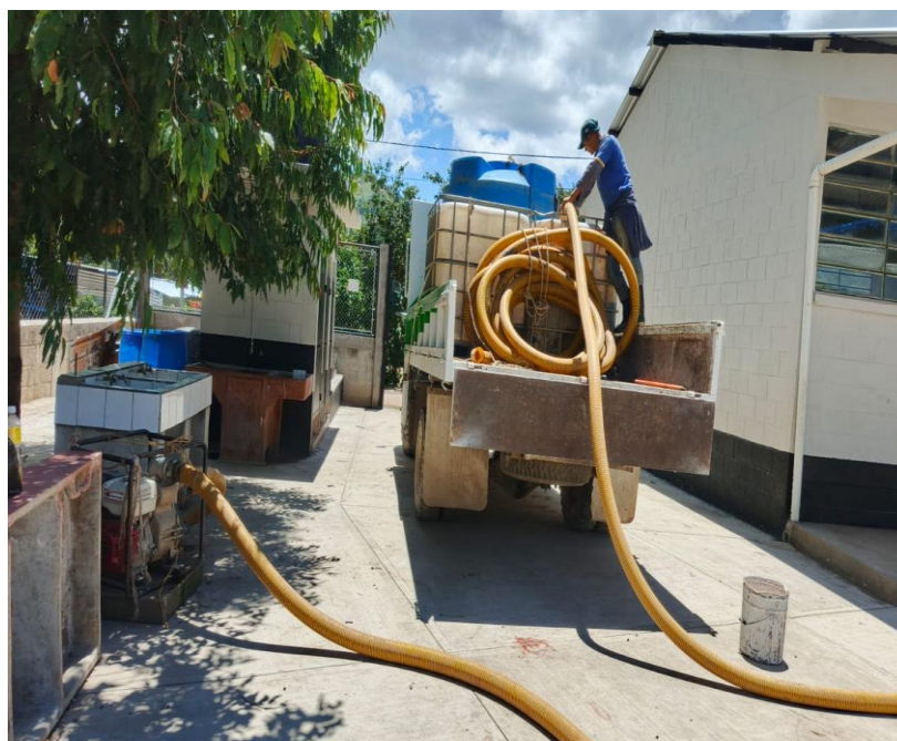
Vaciado de fosa séptica en escuela de Aldea San Sur
