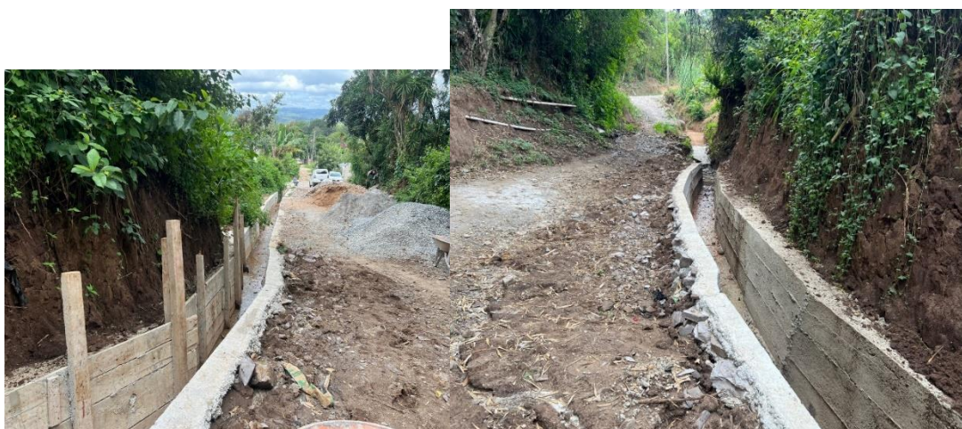
MEJORAMIENTO DE CONDUCCION DE AGUAS PLUVIALES CON CUNETA RECTANGULAR EN ALDEA LOS MIXCOS
