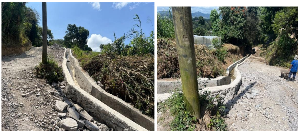
MEJORAMIENTO DE CONDUCCION DE AGUAS PLUVIALES CON CUNETA RECTANGULAR EN ALDEA LOS MIXCOS
