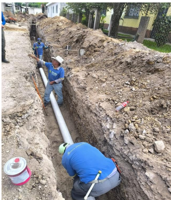
Colocación de tubería para extensión de drenaje en Aldea El Paraíso.
