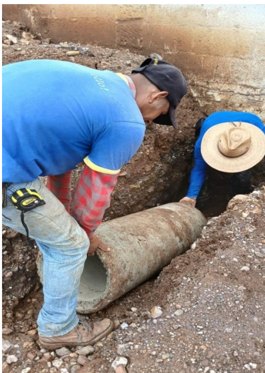
Colocación de servicio de drenaje nuevo en Aldea El Paraíso
