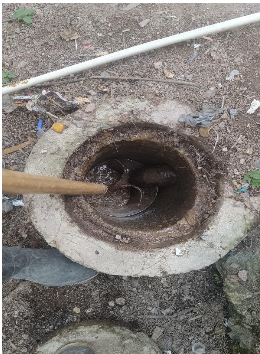
Destapado de candela domiciliar en Cantón Agua Tibia.
